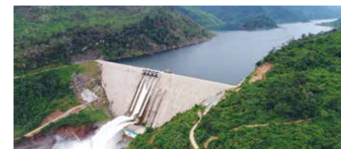
เขื่อนหลัก / Main Dam ปริมาณน้ำสูงสุด / Max. Effective Storage = 1,192 ล้าน ลบ.ม. / MCM
